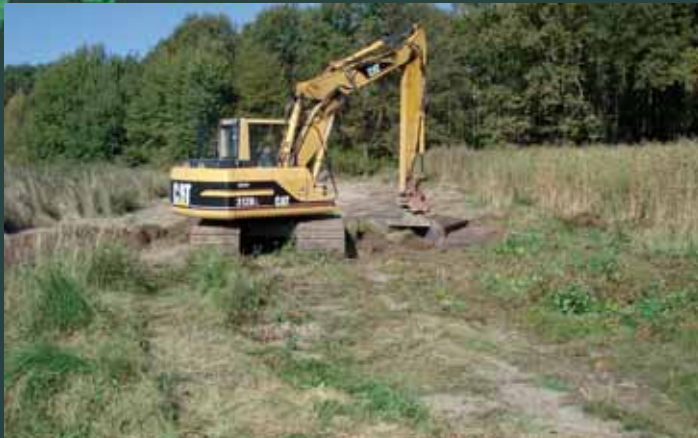
Abflachung eines Teichdammes
